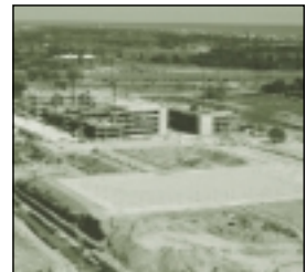
Visió del campus en construcció a maig del 2000.
